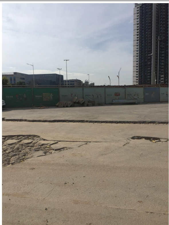
南侧 在建工地
