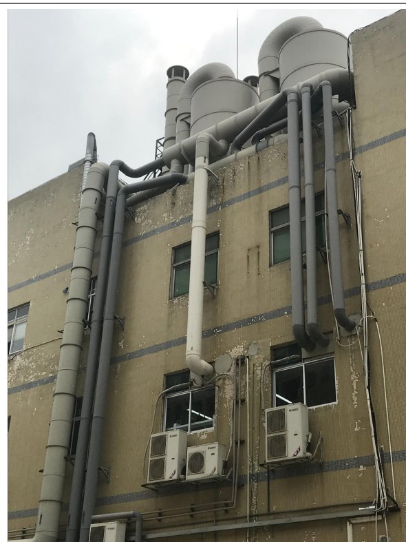
深联电路废气处理设施
