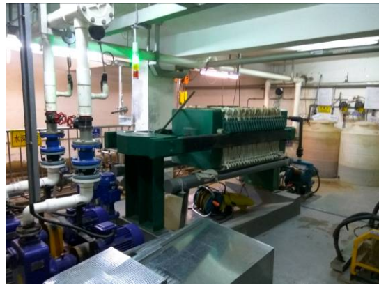
生活污水处理站
