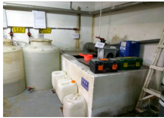
生活污水排放口
