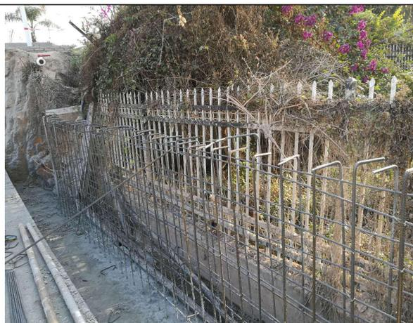
▲澜清一路一侧围挡基础施工
