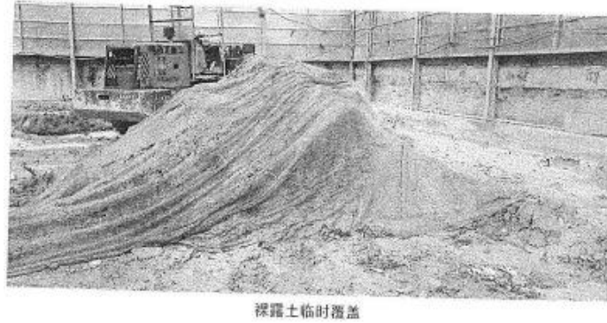
裸露土临时覆盖
