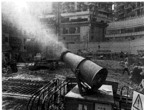
大门口右侧雾泡机运行
