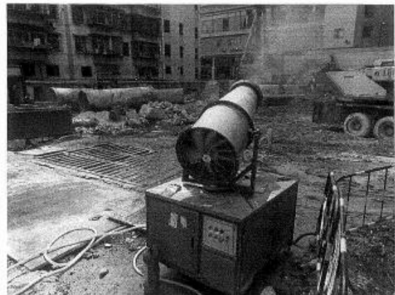
大门口右侧雾泡机运行
