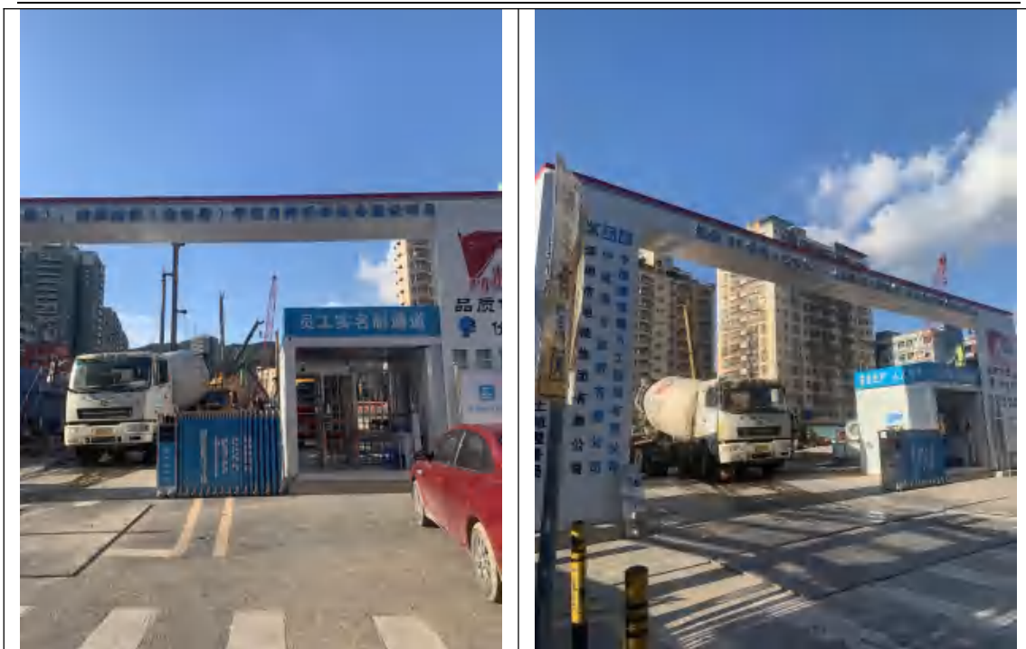
西侧-在建工地
