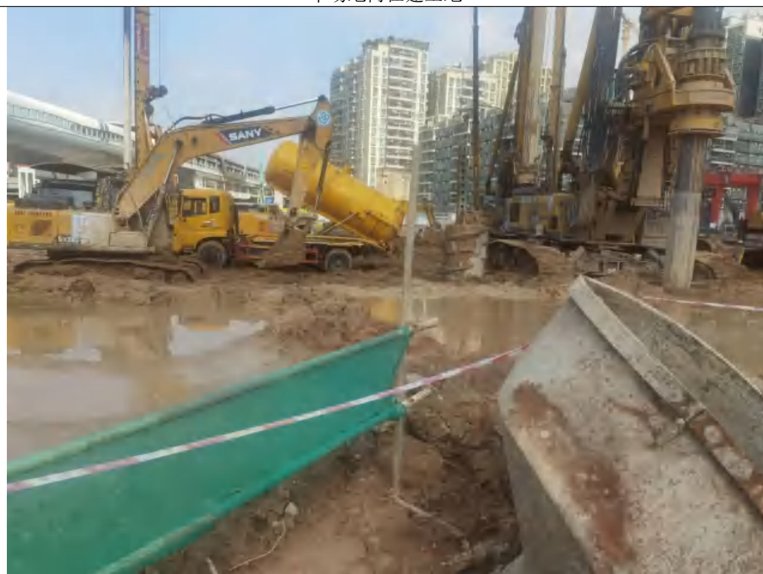
本场地内在建工地
