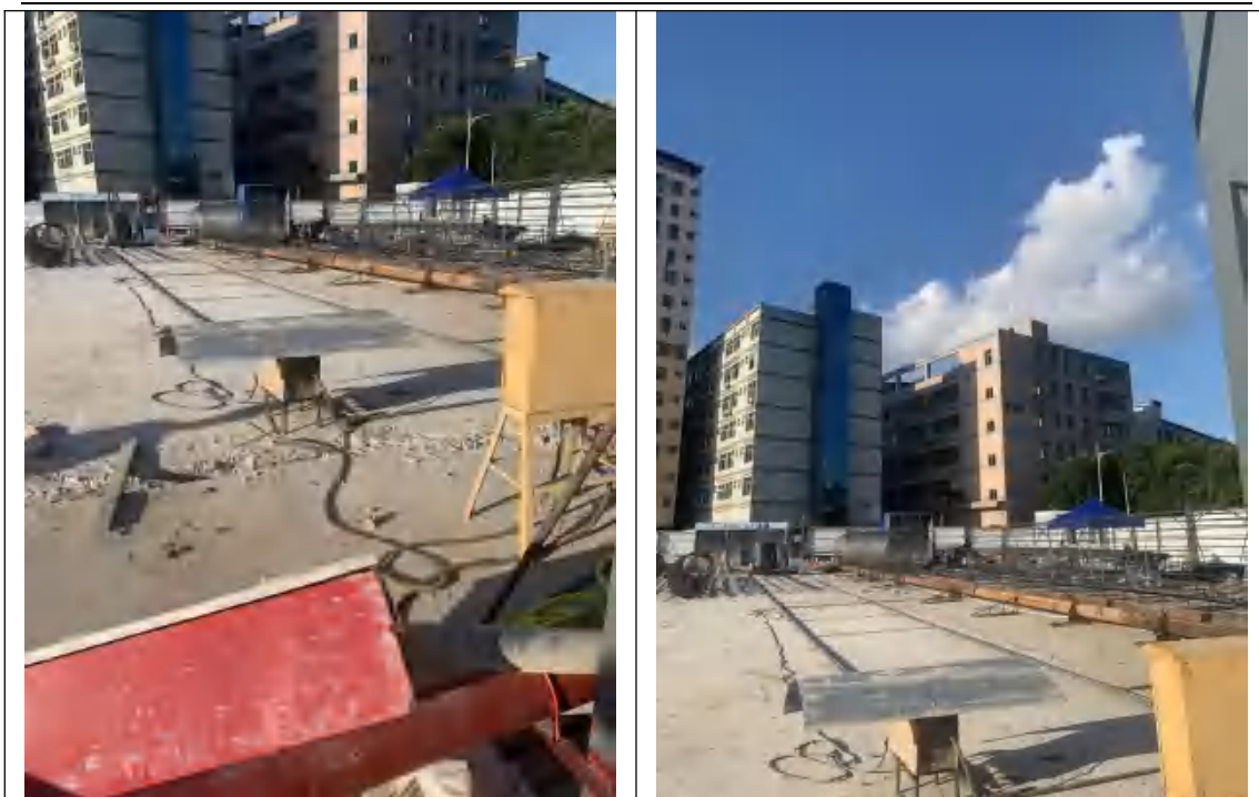
东侧-在建工地
