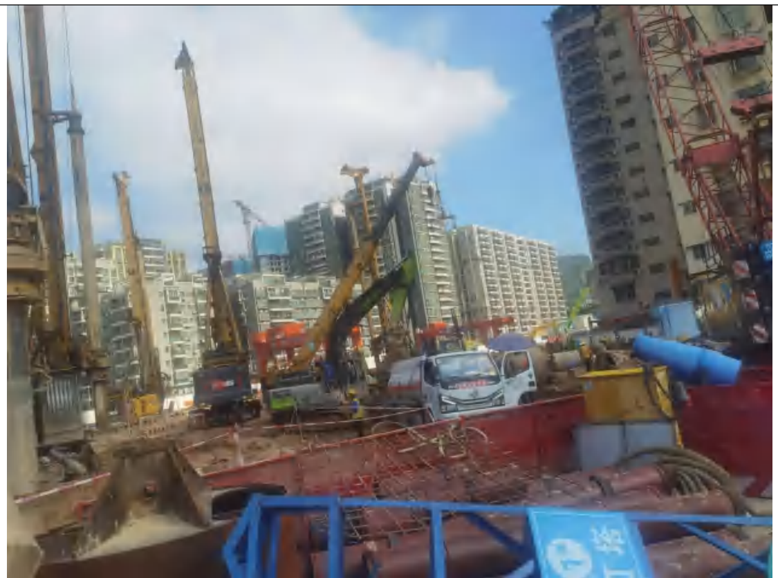
本场地内在建工地
