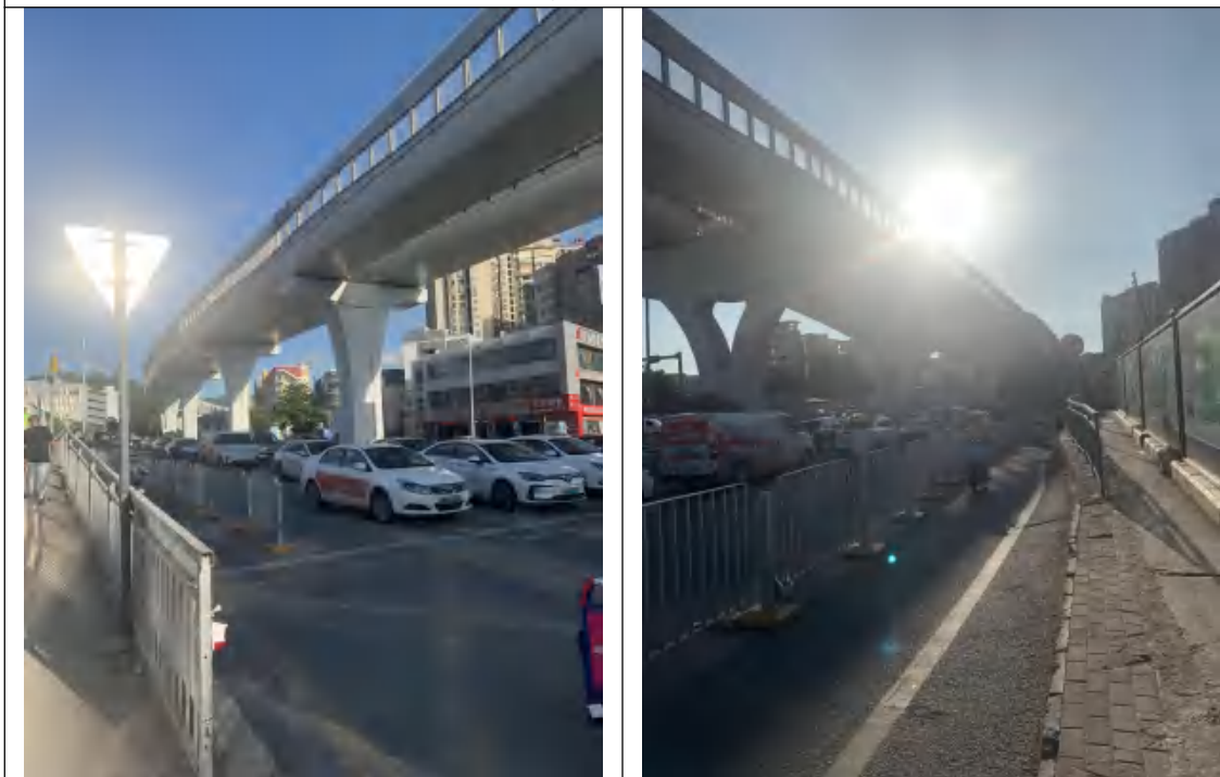
南侧-北环路和地铁 6 号线
