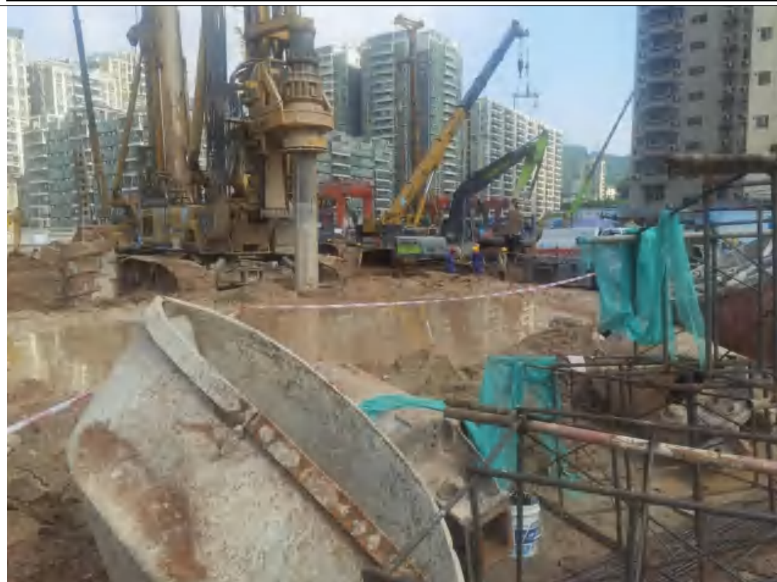
本场地内在建工地
