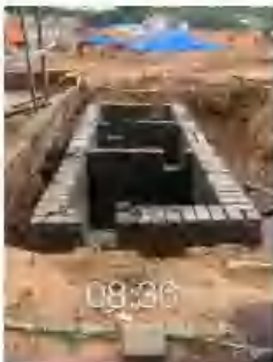
（图一：新增的 3 号沉淀池）
